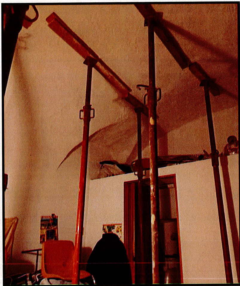
Photo 6 : Etalement plancher bas Mme Aubourg
