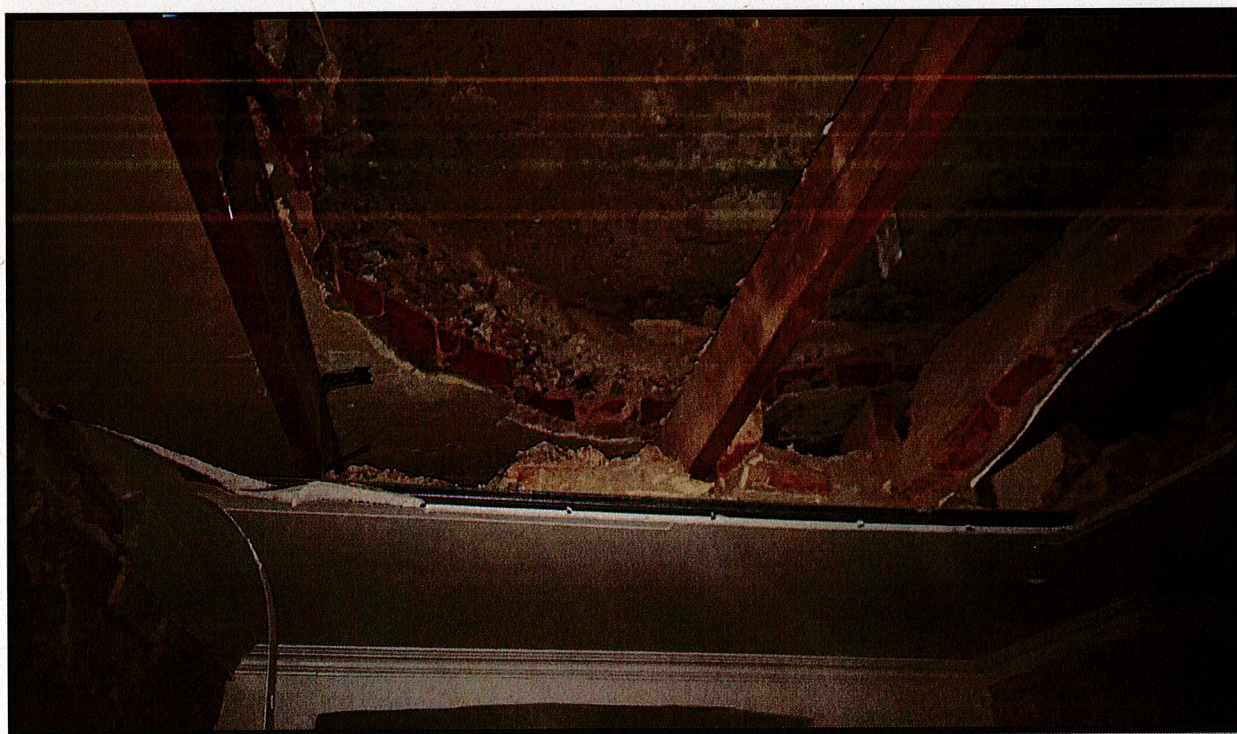
Photo 3 : Structure voûte de type arc : « cintre presque à plat »
