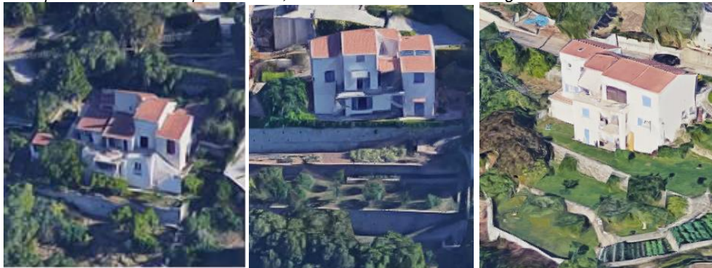
Exemples de petits collectifs ou grandes villas en R+2 regroupant plusieurs logements de formes compactes comprenant des décrochés de façade et de toiture permettant une bonne insertion architecturale et paysagère, la préservation des espaces libres, notamment des terrasses végétalisées ou cultivées
