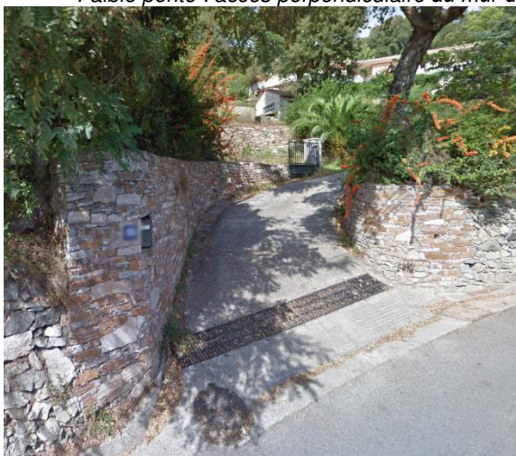
Forte pente : rampe d'accès parallèle au mur de soutènement Exemple de rampe autorisée
