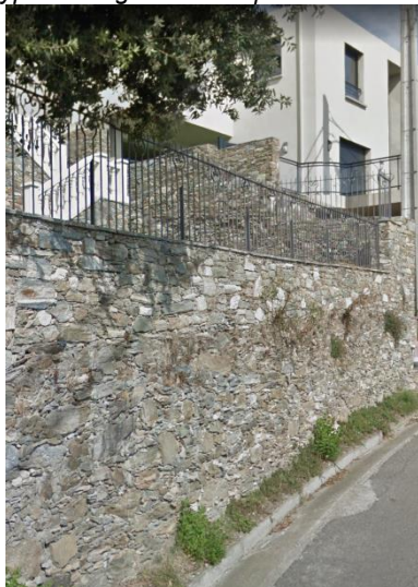
Exemple de murs de soutènement et de clôtures métallique à barreaux rigides de type ouvrage d'art adaptés - autorisés
