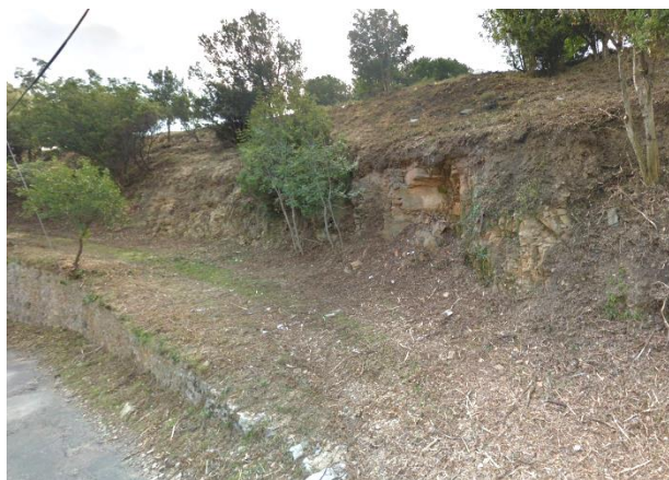
Exemple de rampe où la mise en place d'un second mur de soutènement est nécessaire pour éviter les glissements de terrains.
