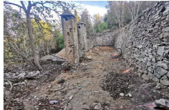
Phase de travaux
