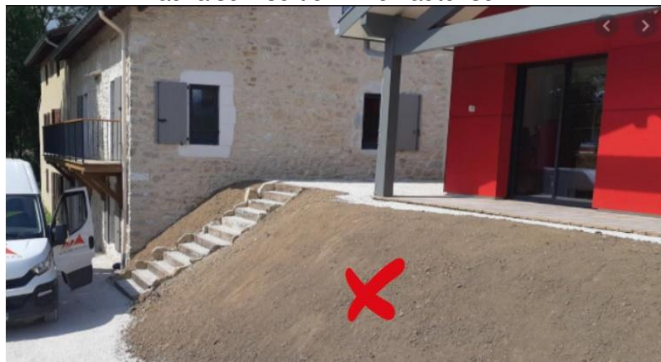
Mauvaise insertion - Non autorisé
