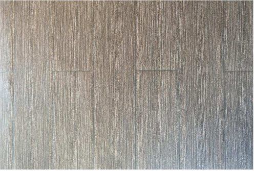
SOL EXISTANT SALLE DE CEREMONIE LAME SYNTHETIQUE A REMPLACER PAR DU GRES CERAME.
